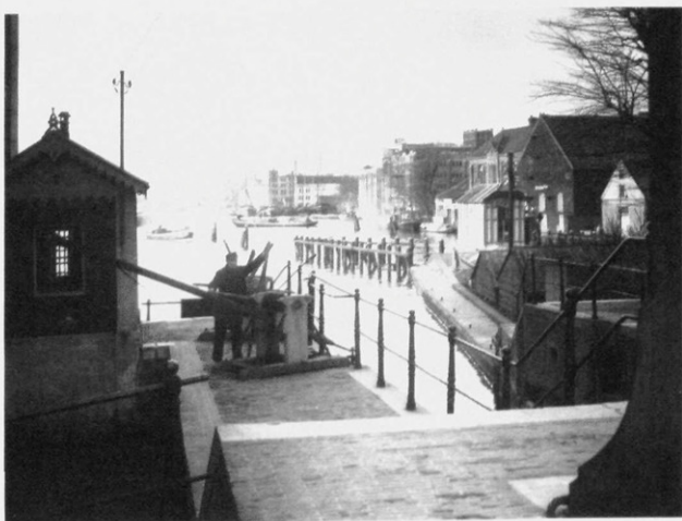
Sluiswachter Jan Dil (?) bij een windkoppel op de sluis, ca. 1890. Links het in 1883 gebouwde wachthuisje.
